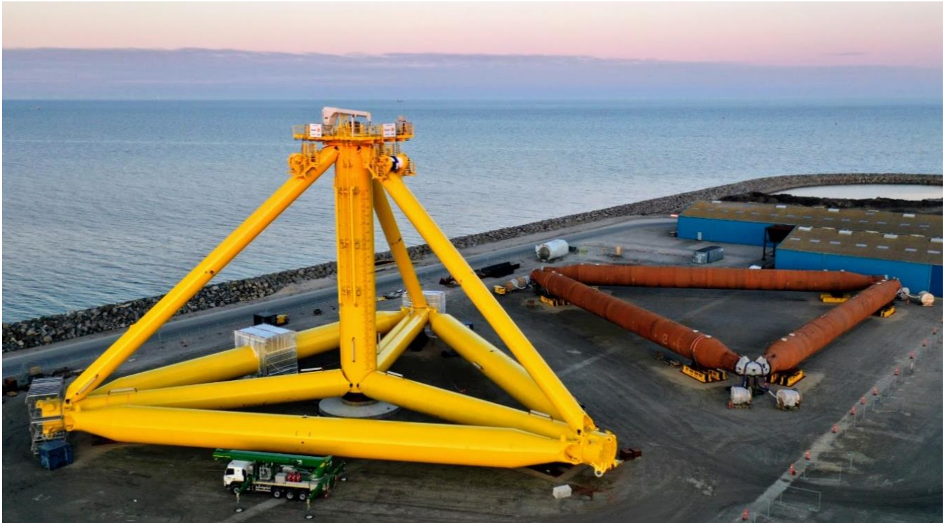
Quai du port de Grenaa, Danemark. Montage de la fondation TetraSpar.
